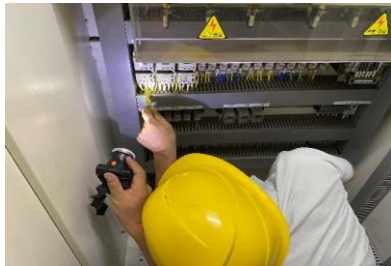
4.进行现场抢修
