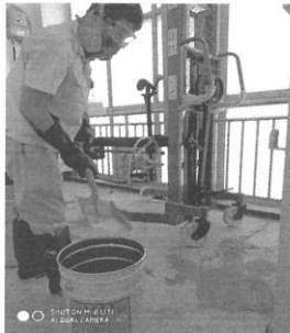
7、圍堵用的消防沙放入危險廢物放置桶中，進行危險廢物處理
