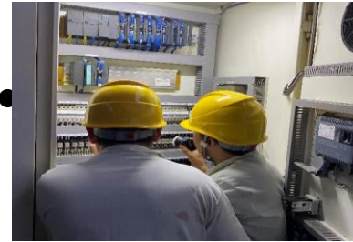
3.技工現場排查故障原因
